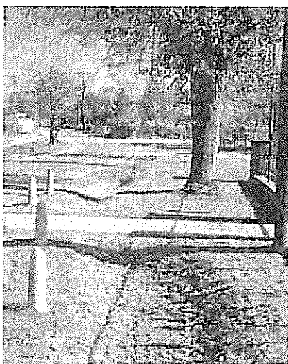
Abb. 12 Mulden-Rigolen-Systeme an einer Straße
